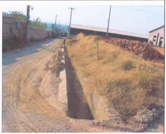
施工期排水措施
