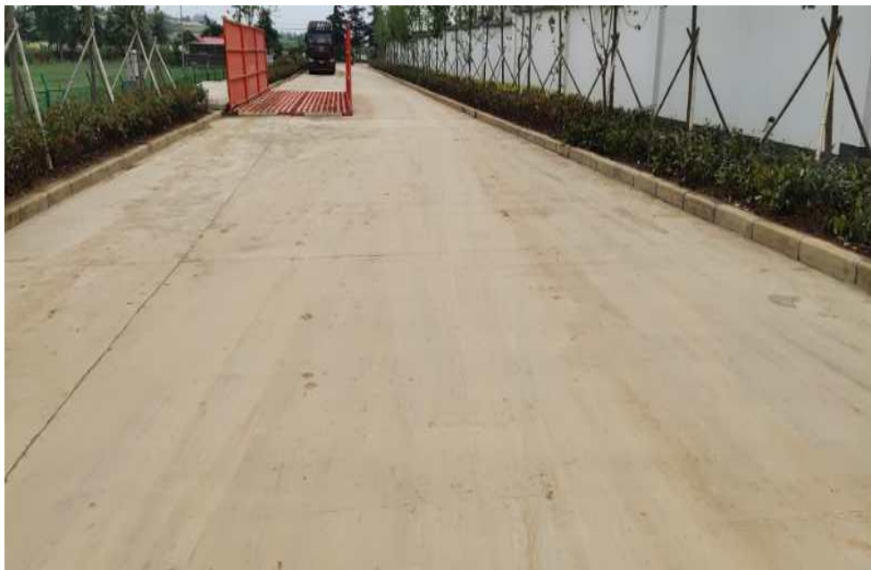
硬化路面及车辆冲洗池
